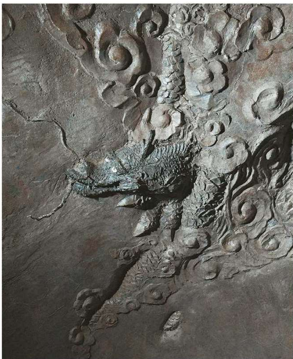
128高地の地下壕の天井にある龍のレリーフ。手前のひげはコンクリートを吹き付けた銅線で立体的に作られている。いずれも千葉県館山市で
