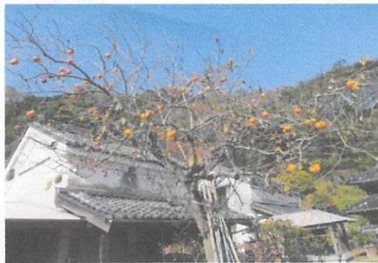
米蔵と文庫蔵 土蔵造り(2階あり)
