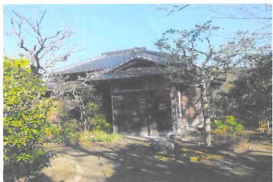
離れ(茶室) 木造平屋建て
