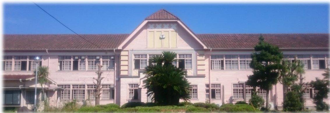
安房南高等学校旧第一校舎（千葉県指定有形文化財）
